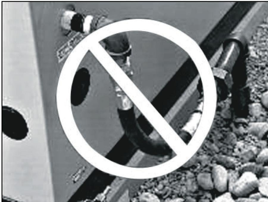
***Figura 5-4. Tendido incorrecto de la manguera flexible***
